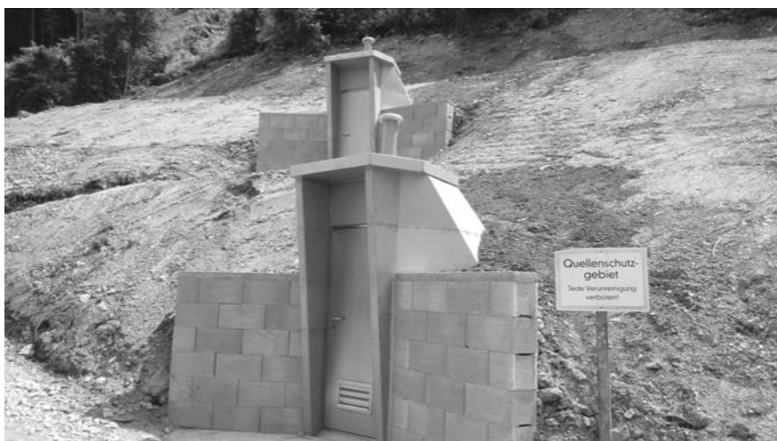
oben: Quellsammelschacht wo alle 4 Quellen zusammenlaufen unten: UV Anlage zur Beseitigung von Keimen (im Bedarfsfall)
